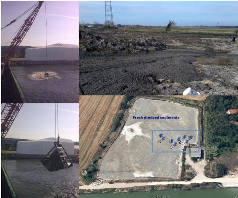
➤ Il trattamento di landfarming è consistito nella periodica areazione del sedimento (1-2 volte/settimana) mediante rivoltamento meccanico per circa 5 mesi
